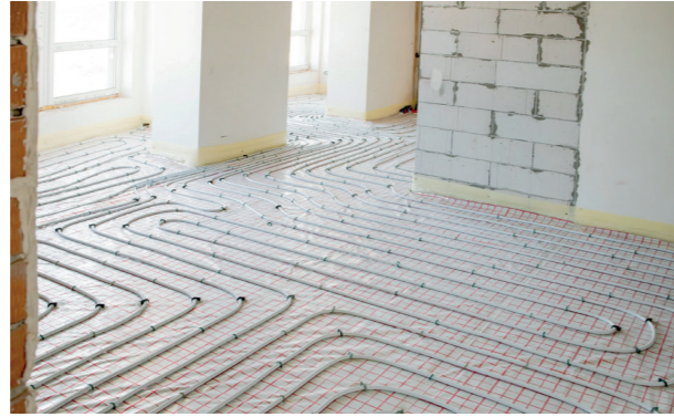
» PE-Kunststoffolie als Dampfsperre mit Heizleitungen vor dem Estrichbau
