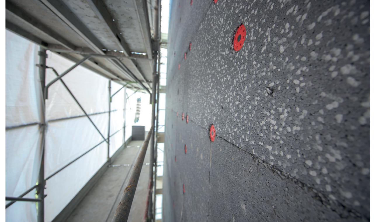
» Wärmedämmverbundsystem aus EPS-Dämmplatten und Kunststoffverdübelung.
