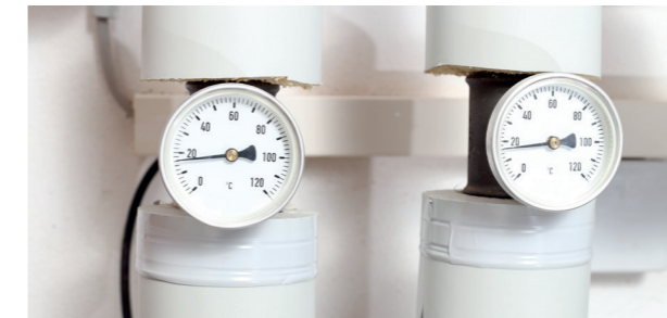
» Wärmedämmung bei Heizverteilerrohren.
