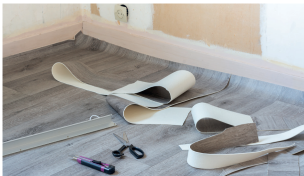
» Verlegung eines PVC-Bodenbelages
