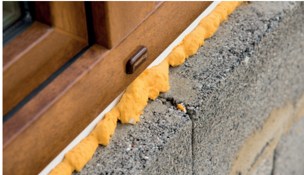
» PU-Montageschaum zwischen Holzfensterrahmen und Mauerwerk
