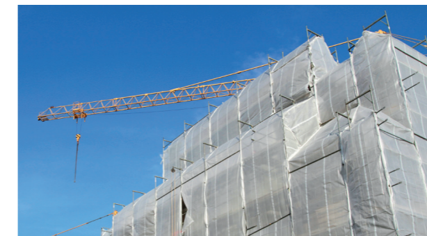
» Gerüstnetz auf einer Baustelle.
