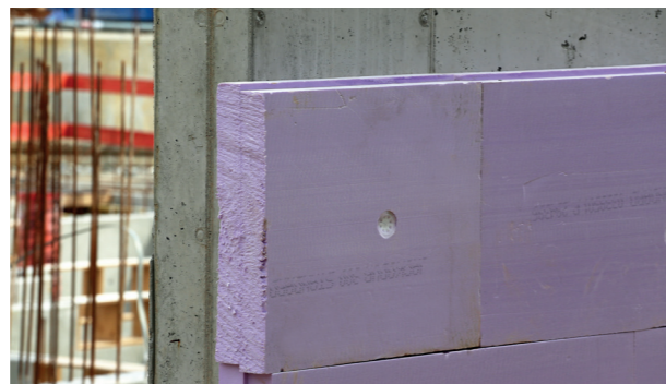
» Kelleraußenwand mit XPS-Wärmedämmung
